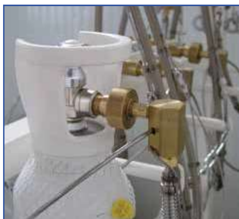
Flexible HP vissé sur la bouteille
