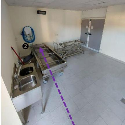
**Version avec civière et extraction centrale** – Dans cette version l'air sera capté à l'extrémité de la cuve **2** (à connecter sur un caisson d'extraction désinfection)
