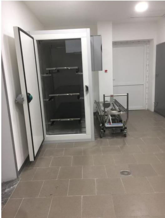
Cellule de conservation pour température en froid positif : -5°C à +10°C, panneaux épaisseur 60 mm, porte de passage libre (H x l) 182 x 80 cm avec ouverture à gauche ou à droite à 180°.
